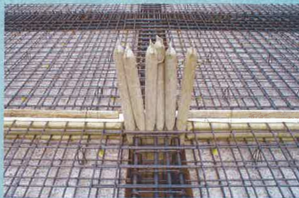
梁・スラブ取付状況(ノロ止めマット併用)
