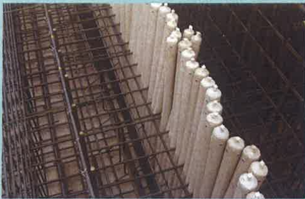
耐圧盤(TF-W)縦使い施工
