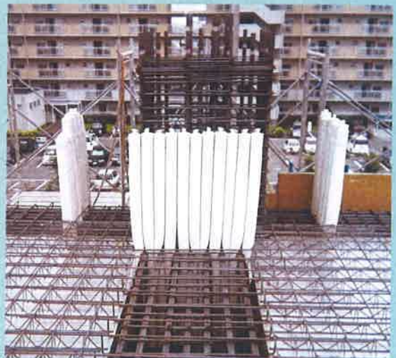
柱・梁コンクリート強度打分け施工
