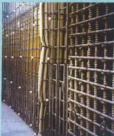
壁型枠施工前のTF取付状況
