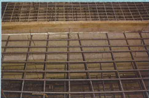
耐圧盤(TF)横使い施工
